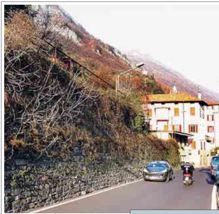
IL PUNTO in cui sorgerà l'autosilo
