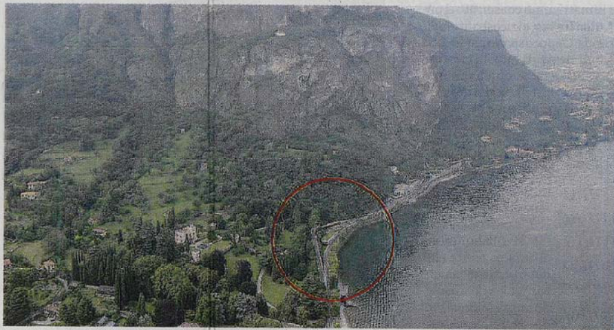
L'area interessata ai lavori della variante della Tremezzina
